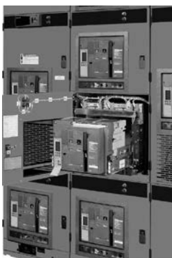
Interruptor NW removido en PZ4
