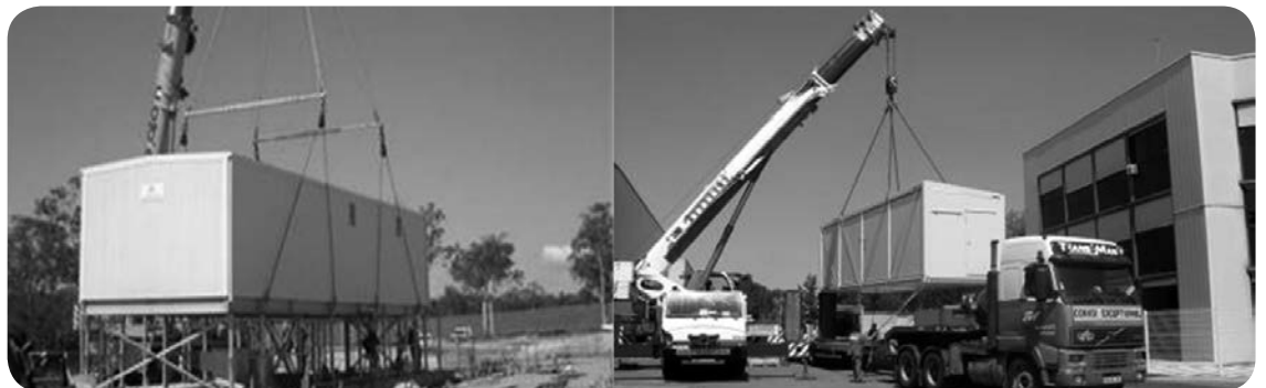
Instalación en sitio
